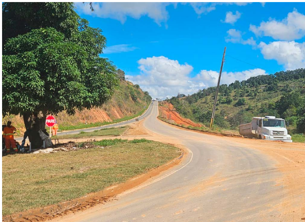
O TREVO DO SANGALI receberá intervenções para melhorar a segurança e a fluidez do tráfego
